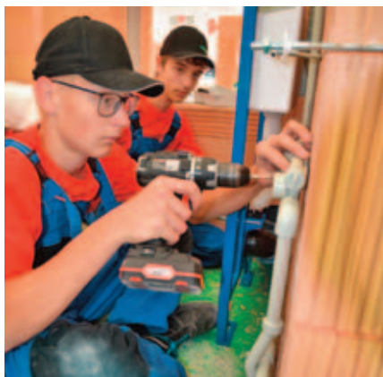
Ukázka práce šikovných instalatérů...
