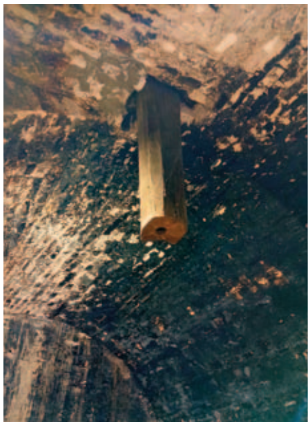
Vrtné pivní potrubí ve sklepení staré radnice. Foto Vojtěch Barcal, 2024
