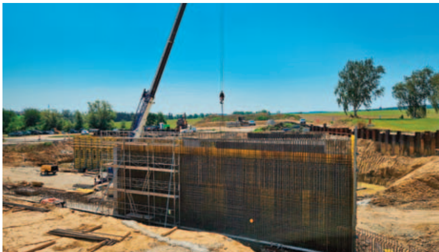
Výstavba mostu, který překlene křížení silnic III/30523 směr Vraclav a III/30527 směr Domoradice. Foto Jan Vlček
